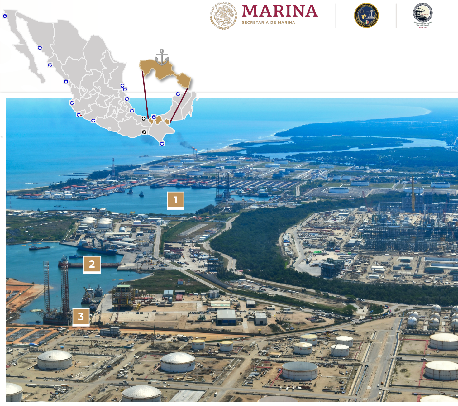
1. Terminal de Abastecimiento
