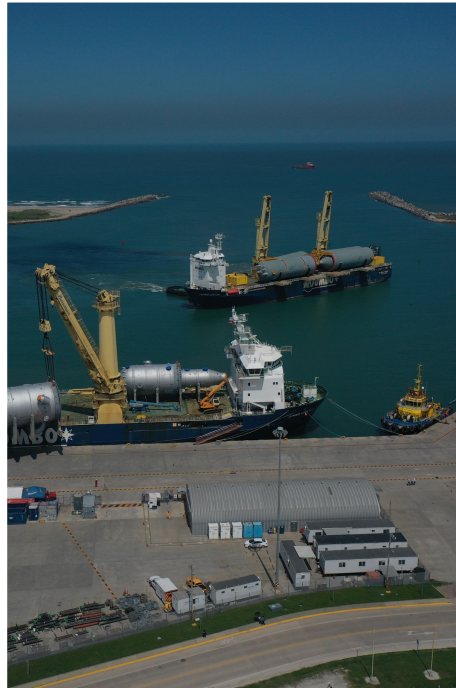
Ampliación del Recinto Portuario.
